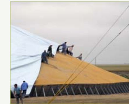
Une bâche conique sur mesure pour les systèmes ronds et un assemblage de sections de bandes pour les systèmes rectangulaires.
