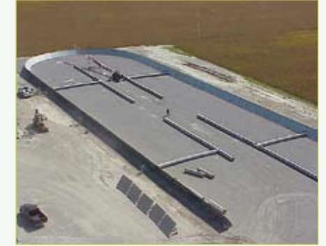
Assemblage des gaines de ventilation et raccordement des ventilateurs.
