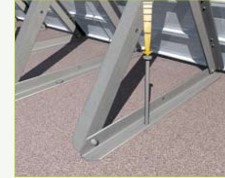
Mise en place des modules et ancrage au sol.
