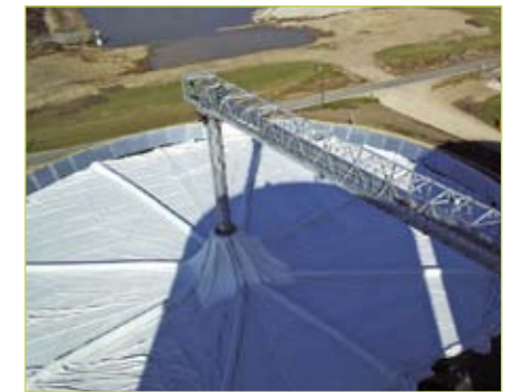
Chargement par manutention fixe, convoyeur à bande et tour de chargement.
