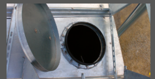
TRAPPE D'INSPECTION DU TOIT
